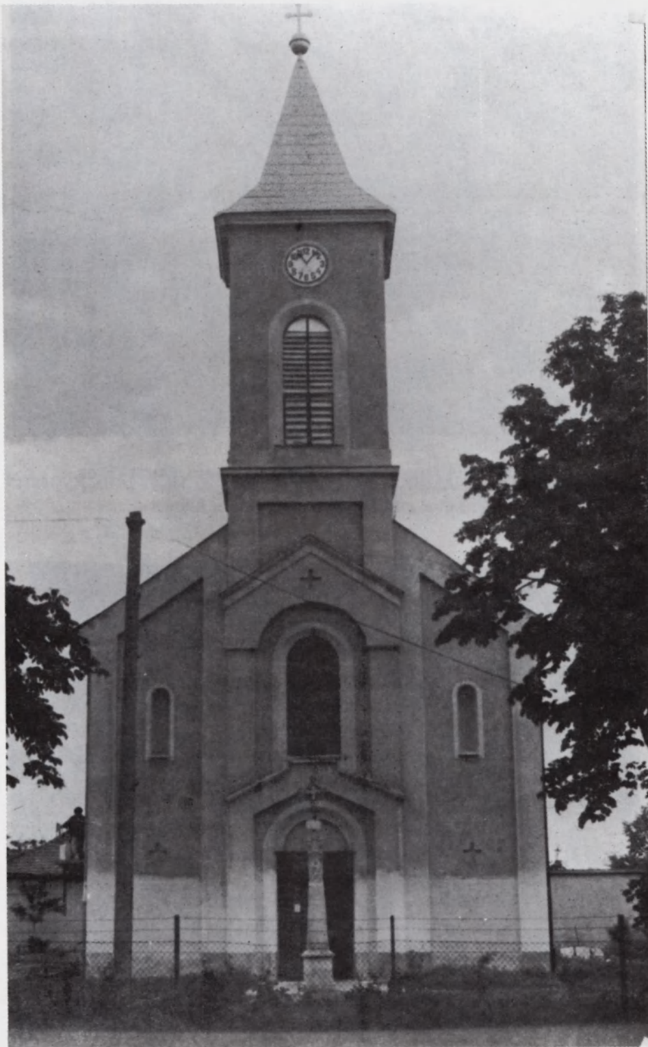
A római katolikus templom 1994 nyarán, felújítás közben
