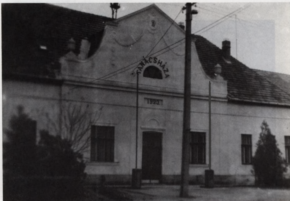
A tanács épülete (Dombegyház)
